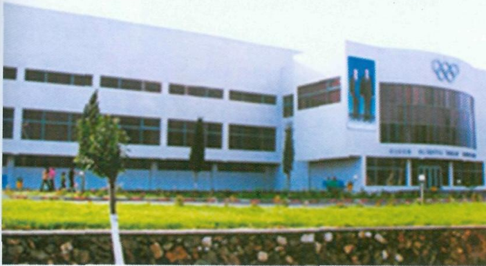
Şəkil 56. Bərdə Olimpiya İdman kompleksi.
