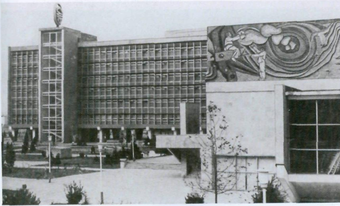
Şekil 28. Kondisioner zavodunun ümumi görünüşü.
