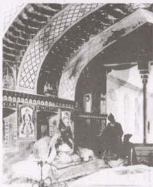
İrəvandakı "Sərdar sarayı". Bədii tərtibatı Mirzə Qədim İrəvaninindir.
