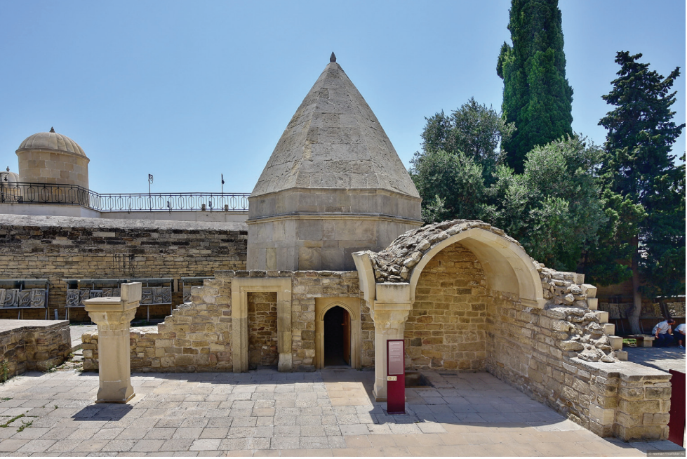
Şirvanşahlar saray kompleksində yerləşən Seyid Yəhya Bakuvinin türbəsi.
