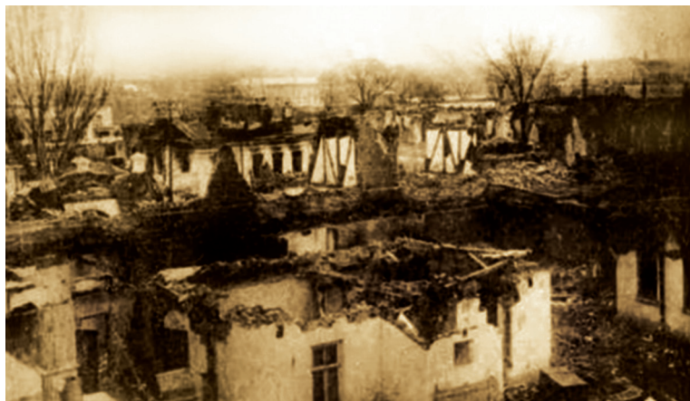
Разрушенные жилые дома. Ферганская долина. 1918г.
